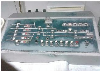
Figura 7 – Pupitrul de comandă instalația CELS
