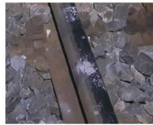
Imaginea nr. 7 : resturi de piatră spartă, sfărâmată de roți
