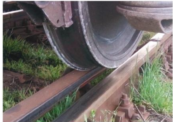
Foto 8: escaladarea contrașinei sub efectul pierderii stabilității căii
