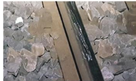
Imaginea nr. 8: Zgărieturi pe șină provenite de la piatră spartă care a patinat sub roți
